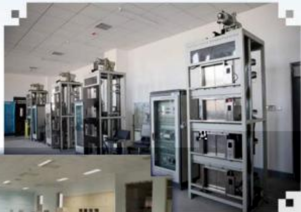
智能电梯安装调试维护训练场所
